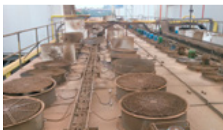
Antes do Retrofit
