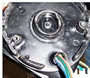
Caixa de ligação Derretida
