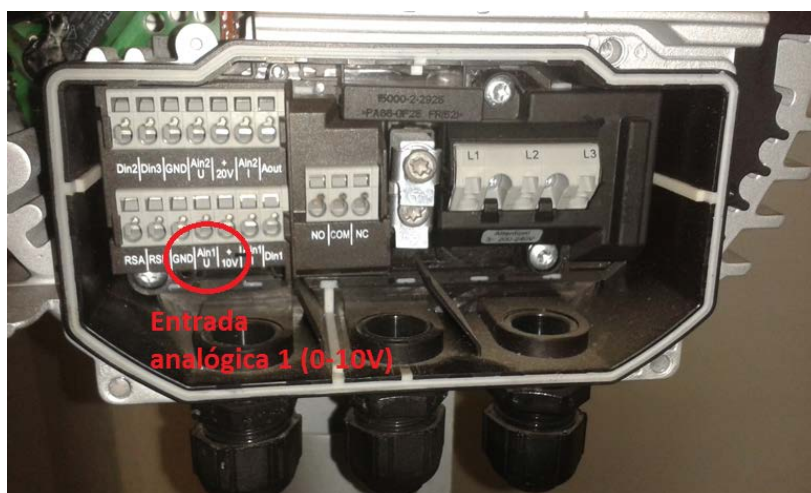
Ligação do sinal analógico para controle de velocidade do ventilador.
